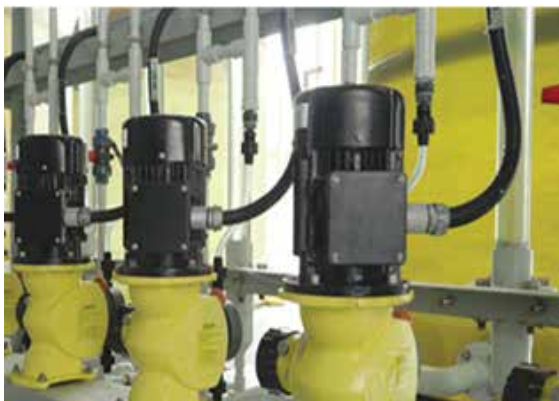
Hình 4: Các máy bơm hóa chất
