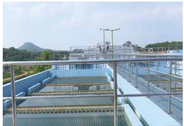
Hình 1: Ảnh nhà máy nước Yên Bình
