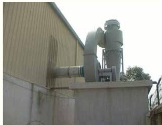
Hình 3: Hệ thống hút bụi, dập bụi cyclone
